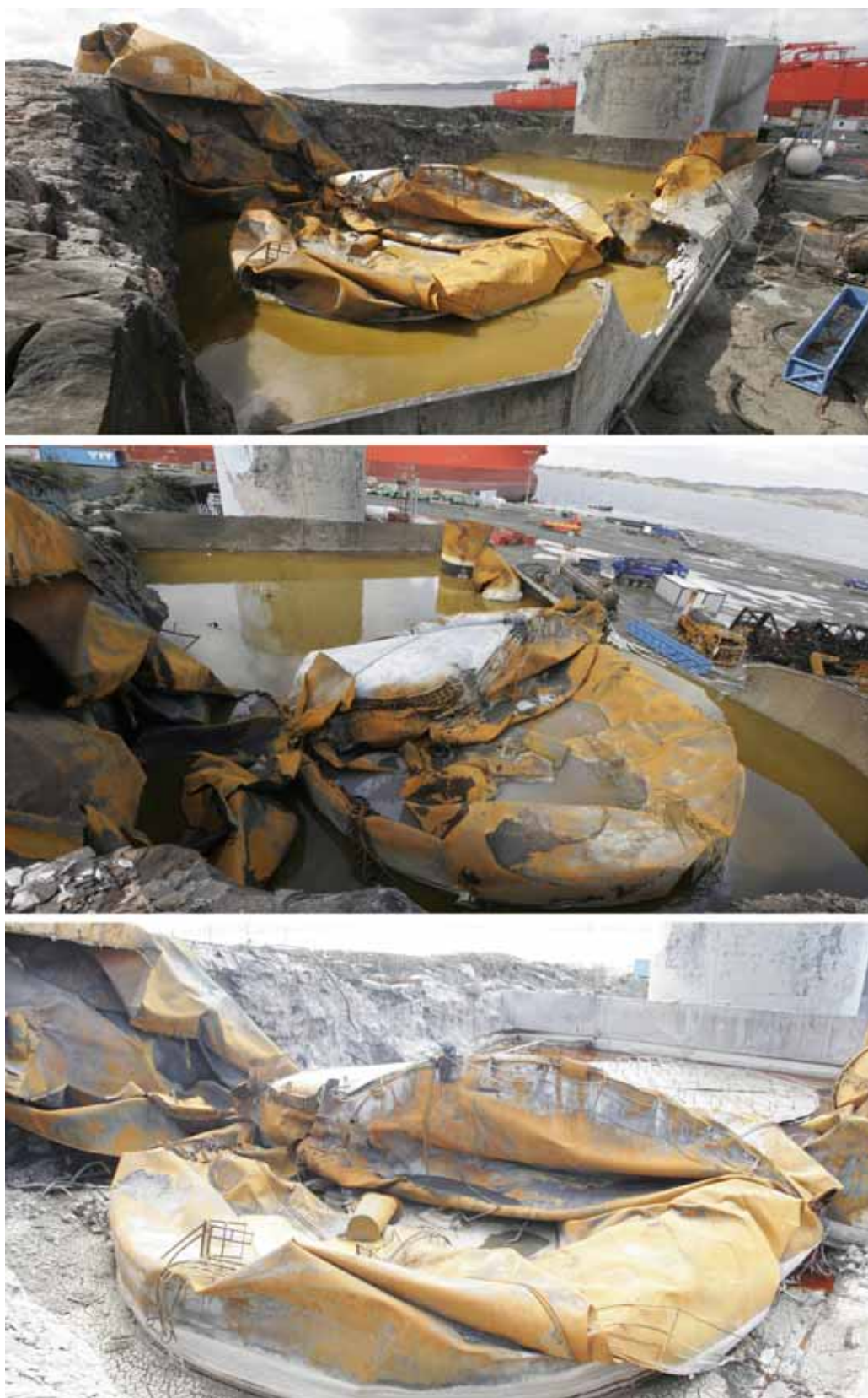
Figur 3-3 Tankgård II sett fra nord: det øverste bildet viser det som var igjen av de fem tankene, samt skaden på ringmuren og vindeltrappen (bilde fra Politiet, tatt 25.05.2007); de to nederste bildene viser restene av tankene T3 og T4 (bilder fra Politiet, tatt henholdsvis 25.05.2007 og 31.05.2007).
