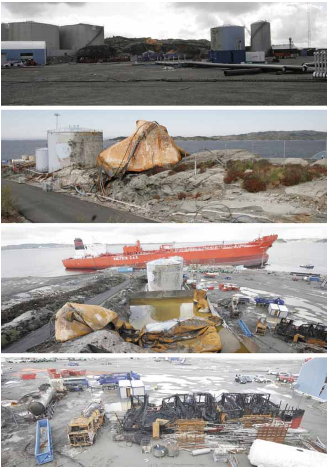
Figur 1-6 Oversiktsbilder som viser tankanlegget til Vest Tank AS på Sløvåg i dagene etter ulykken 24 .mai 2007. Bildene er tatt av politiet og viser, ovenfra og ned: Tankgård II sett fra kaien (25.05.2007); restene av tank T3 sett fra veien inn til anlegget (26.06.2007); Tankgård II med Tankgård I og M/T Karen Knutsen i bakgrunnen (25.05.2007); skader på kjøretøy og den røde brakkebygningen (25.05.2007).
