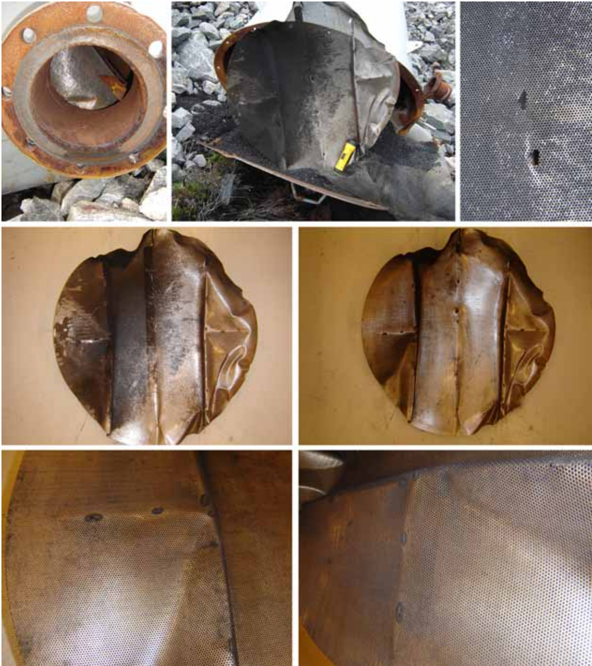
Figur 6-5 Perforert plate fra bunnen av luftfilteret med aktivt kull: platen sett gjennom innløpet til filteret (øverst til venstre); platen etter at den ble tatt ut av filteret, med sotlignende avsetning på ca. halve overflaten (øverst i midten); huller i platen over gamle sveisepunkt som trolig skyldes at platen ble deformert idet filteret landet (øverst til høyre); platen før (til venstre) og etter at (til høyre) det sotlignende belegget ble tørket bort (i midten); tydelige tegn til fargeforandring på materialet som tidligere var dekket av det sotlignende belegget tyder på lokal oppvarming (nederst venstre og høyre). Foto av T. Skjold.
